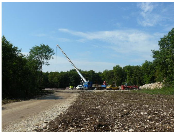
Chantier éolien à Ivry-en-Montagne
