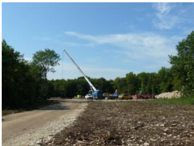
Chantier éolien à Ivry-en-Montagne
